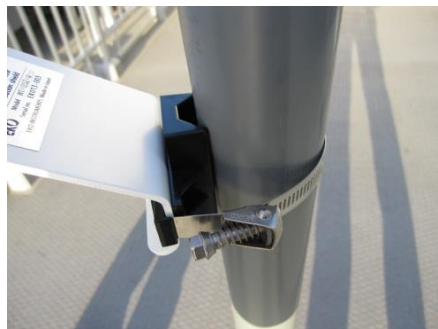
図 4-10. ポール取り付け時
