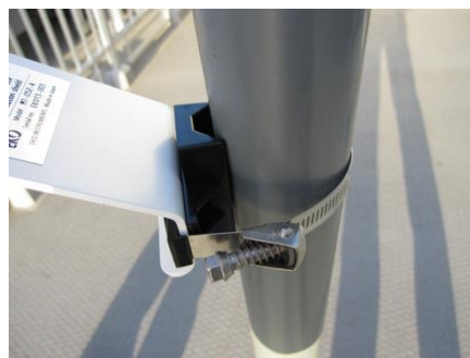
図 4-7. ポール取り付け時
