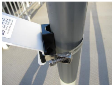
図 4-8. ポール取り付け時
